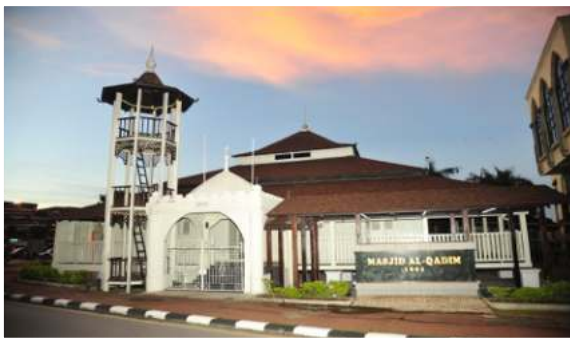
Masjid Al-Qadim selepas kerja-kerja baik pulih dijalankan.
